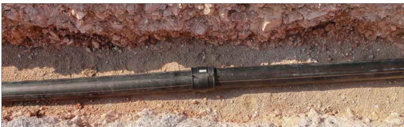
Mehaničke PE i MS spojnice ograničene su na manje promjere cijevi, te se uglavnom koriste za vodoopskrbu.
